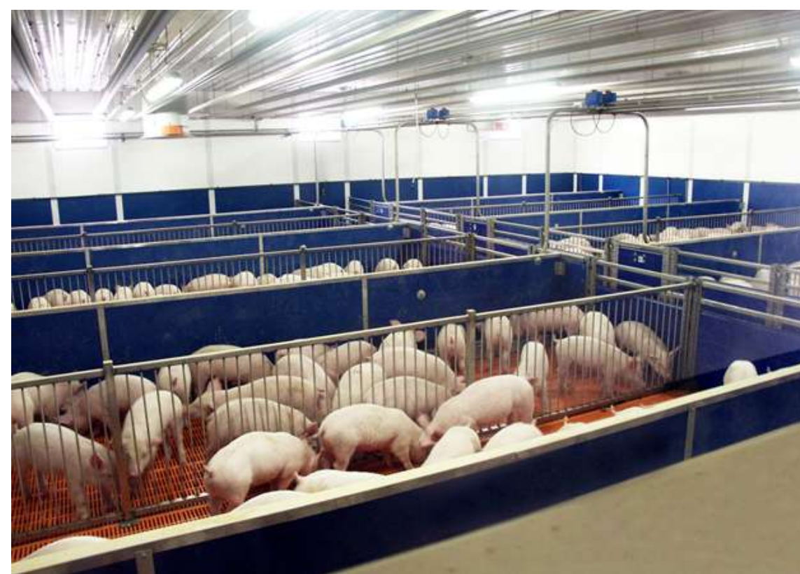
Строительство свинарника и зерносклада ООО "Согласие" (Заводоуковский ГО)
